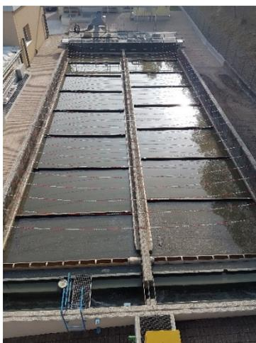
L'opération consiste, pour chacun des deux décanteurs, en une vidange, au remplacement des chaînes, des roues dentées et des différentes parties d'usure liées aux parties mécaniques et mobiles. Il conviendra également de procéder à une inspection du fond et des bétons.
